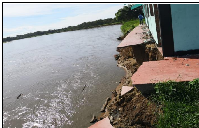
Socavación sobre cimentaciones de la escuela antigua
