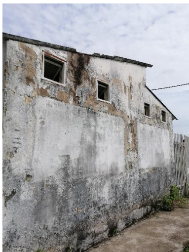
Figura -6 -7 -8. Humedad en instalaciones de la morgue
