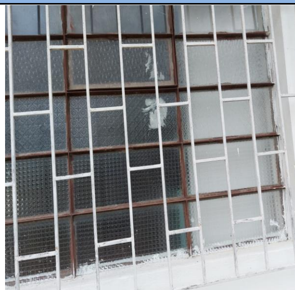
Foto 14. Deterioro en el esmalte de las ventanas
