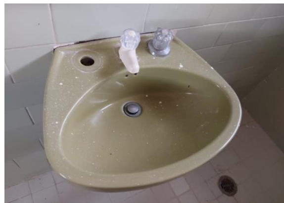
Foto 10. El lavamanos se encuentra sin varias de sus partes y sin funcionar
