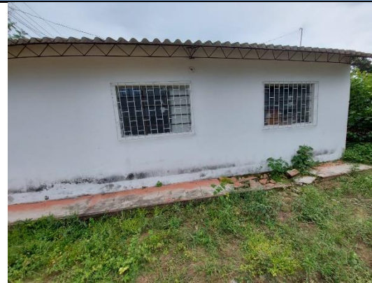
Foto 4. Deterioro de paredes a causa de humedad en la superficie.
