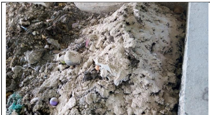
Aplicación de cal viva en los lechos de secado para evitar los malos olores
