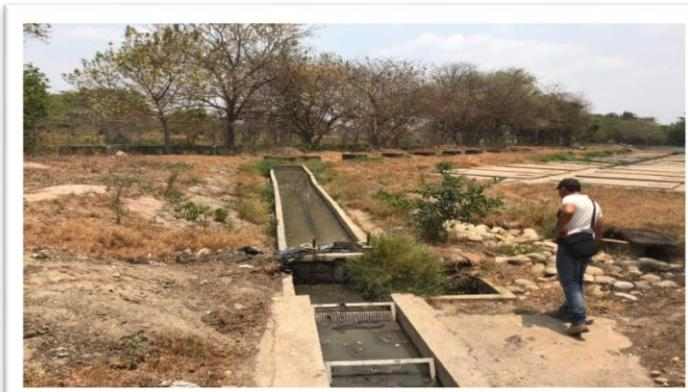
Estructura en concreto reforzado en regulares condiciones, la cual presenta ausencia de equipos necesarios para el tratamiento primario, tales como cribas o rejillas de sólidos y equipo de aforo inicial como vertedero con rejilla, estos equipos se encargan de que el material sólido como plásticos y material vegetal no llegue a los tanques de tratamiento y puedan ocasionar fallas “taponamiento” en los diferentes conectores hidráulicos que encontramos en la planta.
