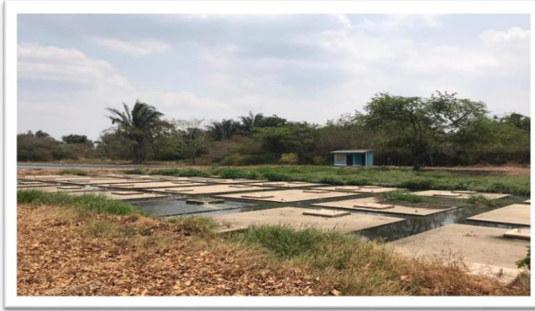
La planta de tratamiento de agua residual del municipio de hato corozal incluye en sus unidades de tratamiento 45 tanques en concreto que funcionan de forma filtro anaerobio de flujo ascendente utilizando tres en línea formando 15 trenes de tratamiento lo que nos da una forma amplia para mantenimiento ya que podemos sacar de servicio hasta 5 líneas de tratamiento y funcionar con 10 durante el mantenimiento.
