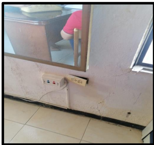
Figura -2 -3 -4 -5-6-7. Humedades en muros y viga canales, deterioro parte eléctrica.
