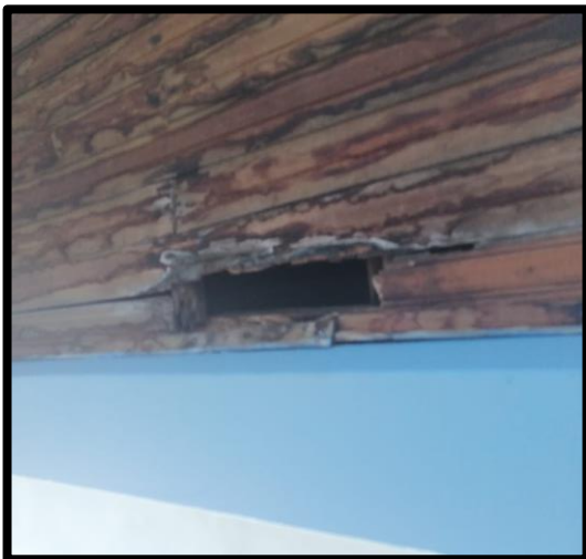
Figura -8-9-10. cielo Rasos deteriorados
