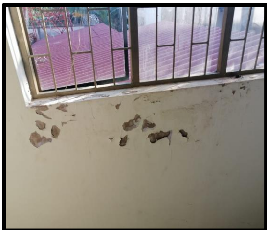
Figura -2 -3 -4 -5-6-7. Humedades en muros y viga canales, deterioro parte eléctrica.
