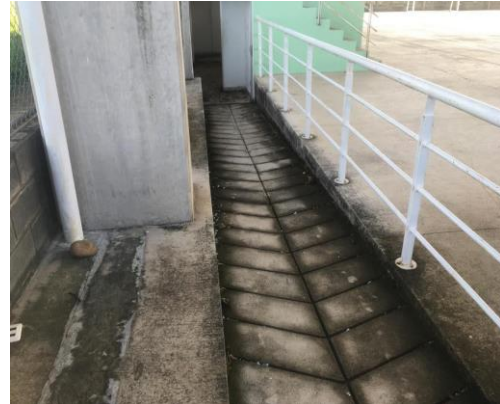
Evidencia de rampa con problemas desagüe
