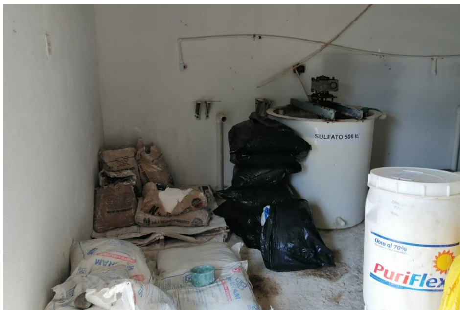
Imagen 6. Tanque de dosificación de sulfato e insumos almacenados.
