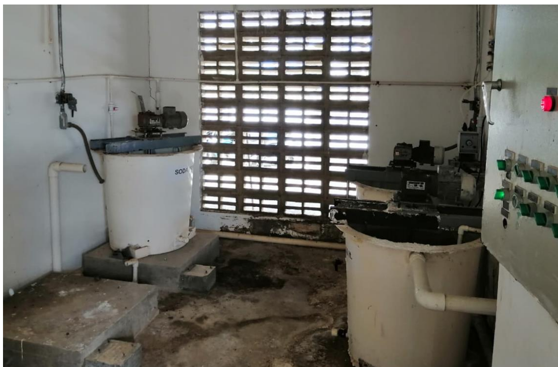
Imagen 7. Cuarto de tanques de dosificación.
