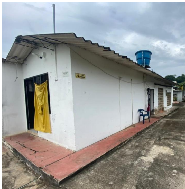
Imagen 10. Grietas en la placa de contrapiso exterior.
