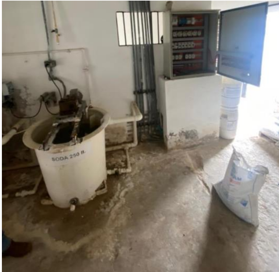
Imagen 3. Tanque de dosificación de soda así.
