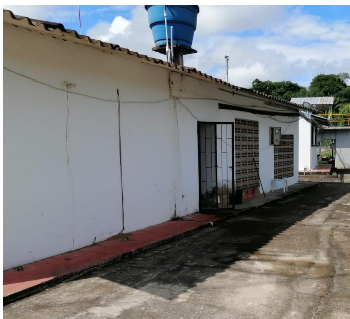
Imagen 2. Vista posterior de la edificación actual.
