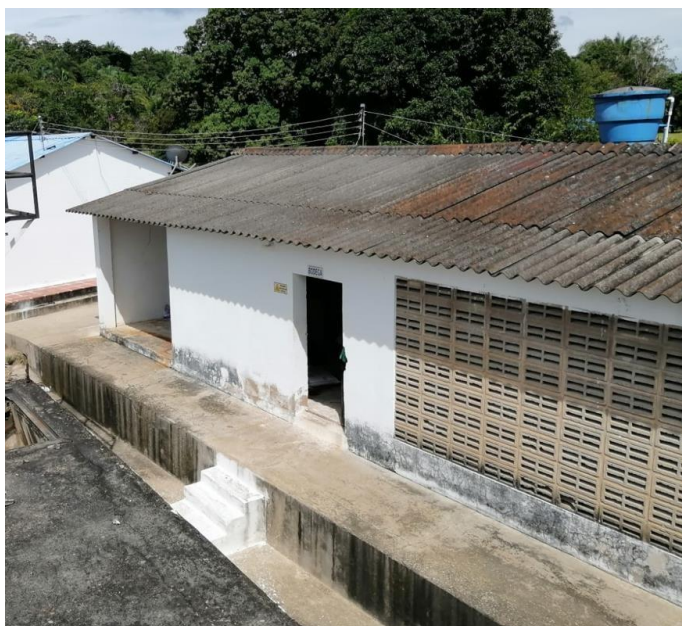
Imagen 1. Vista general de la edificación actual.
