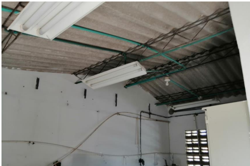
Imagen 17. Tuberías e instalaciones eléctricas expuestas.
