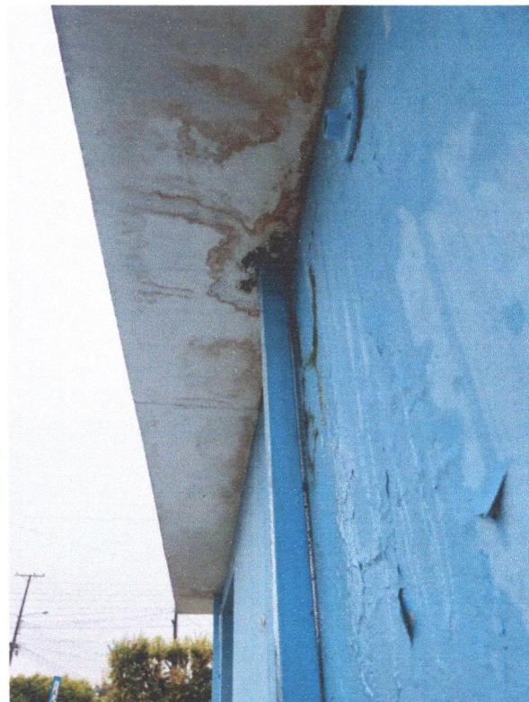
Figura 2. Daños en el cielo raso exterior
