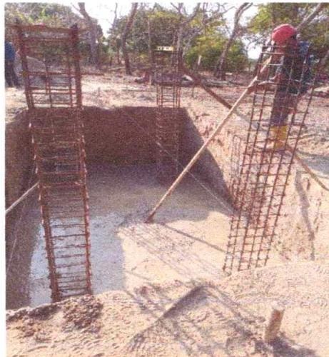
SE FUNDEN ZAPATA ZONA OCCIDENTAL, CONCRETO 3000 PSI, SE TOMAN MUESTRAS PARA TESTIGOS DE RESISTENCIA, PARA POSTERIORMENTE LLEVAR A LABORATORIO.
