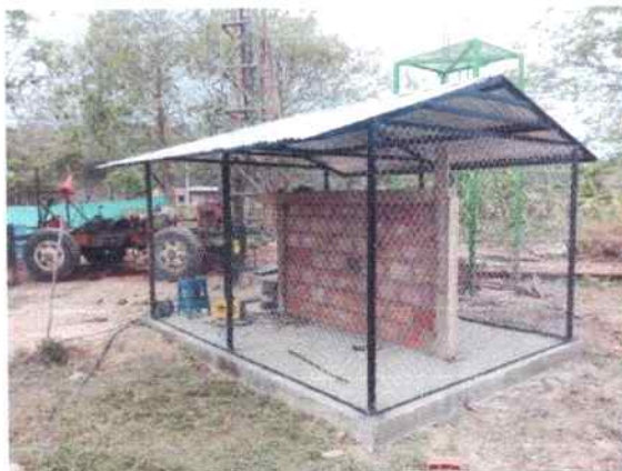
Imagen 5. Caseta para planta de tratamiento y estructura para tanque elevado.
