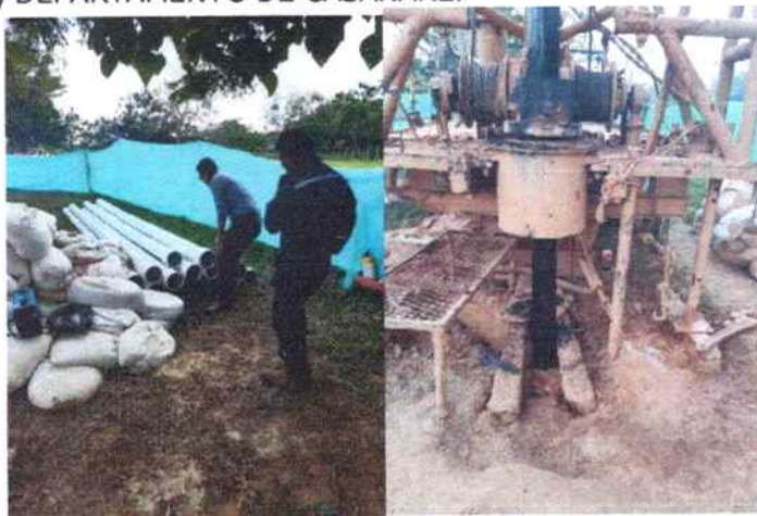
Imagen 4. Verificación de calidad de tubería y filtros para pozo, revisión de equipo de perforación.
