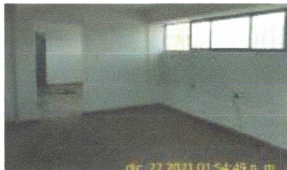
Foto 10. Pintura interior sobre pañetes e instalación de modulo led 18W
